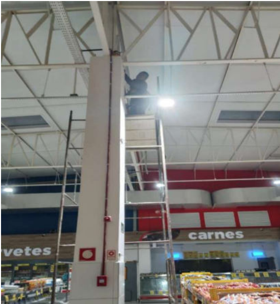
Instalação do sistema de alarme
